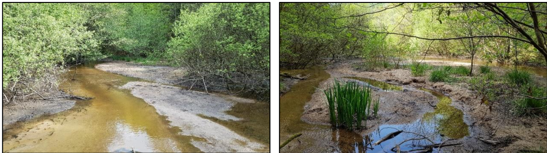
Figure 28 : vues de la retenue amont montrant les atterrissements en voie de végétalisation
