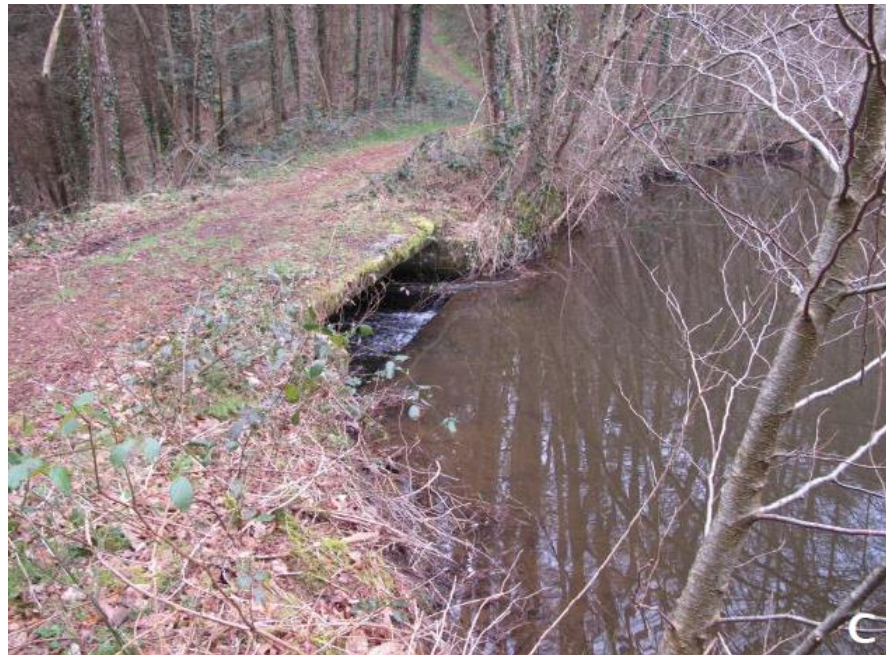
Figure 26 : vues de surverse du plan d'eau et de la crête de digue (C)
