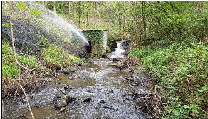
Figure 27 : vues du local de la turbine à l'aval de la digue
